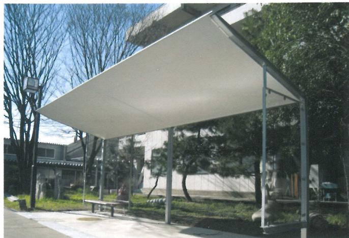
●抗張力たて300kg、よこ280kgの強度を実現、美しさに安全性を兼ね備えています。●不燃の膜材料を使用していますので、準防火地域にもテント倉庫、荷さばき場の庇、膜構造建物を建てることができます。
